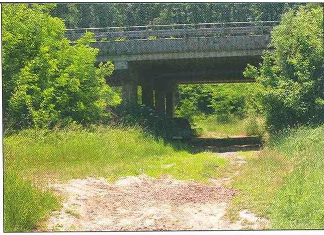
Többcélú aluljáró, ahol a nagyvadak is átjutnak az autópálya alatt
